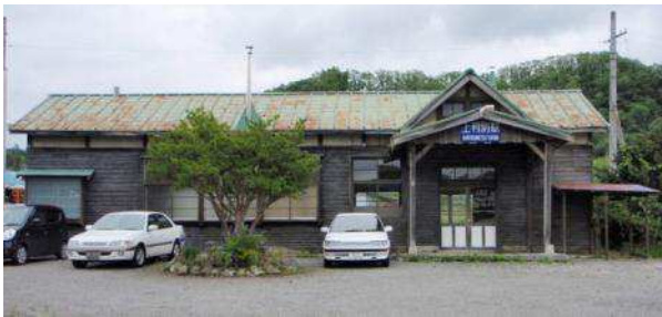
〔旧上利別駅舎 昭和10年築 足寄町〕
